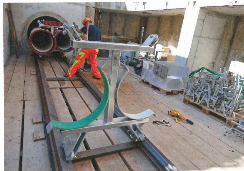
Einzug von zwei Gussrohren gleichzeitig mittels speziell entwickelter Doppelrohrschelle.
