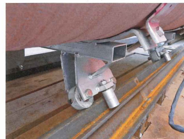
Auf vormontierten Schienen rollen die von der anderen Seite aus gezogenen Rohrschellen langsam durch den Tunnel.
