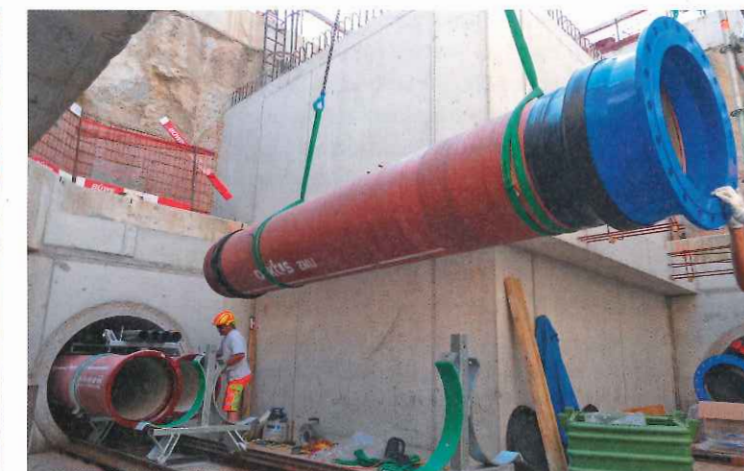
Auf der Einbauseite des Tunnels herrschten sehr beengte Platzverhältnisse. Im Bild: Montage eines Rohres auf die Transportschellen.
