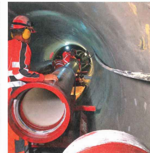
Rohrmontage DN 400 mit Zink-Epoxy-Beschichtung an der Industriestrasse.
